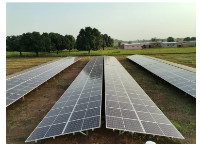
Mali: Ländliche Elektrifizierung
