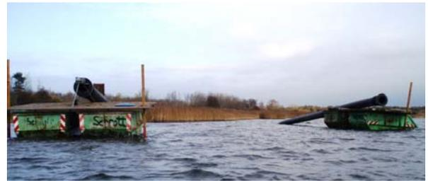
Das gesamte Onshore Projekt hatte eine Gesamtlänge von 14.500 m. Davon wurden 3.600 m in geschlossener Bauweise mittels HDD realisiert.
